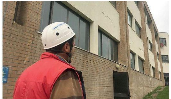
I controlli dei tecnici su una delle scuole lesionate dal terremoto
